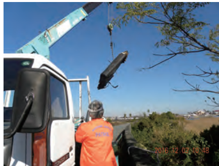
2016.12 手で拾えない重たくて大きい ゴミはユニック車を出して回収します。
